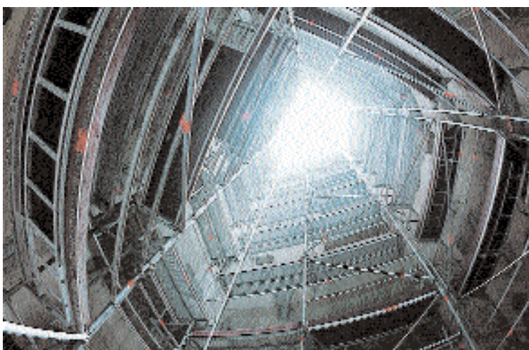
La diagonalización de los andamiajes. Procedimiento de seguridad en beneficio de la solidez estática de las estructuras.
