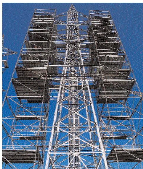
Para conocer en número de módulos en donde se han de colocar diagonales y su correcto montaje, véanse los capítulos de Instrucciones de Montaje.
